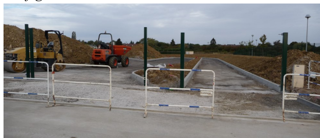
Nouvelle déchèterie : rue de l'innovation dans l'extension de la zone industrielle.
